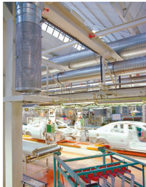
Diffuseur basse vitesse en compensation d'air extrait. Voir chapitre Diffusion.
